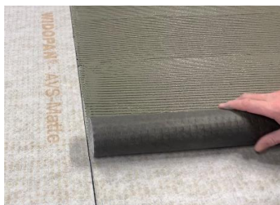
Bild 4: Entkopplungsmatte aufbringen
