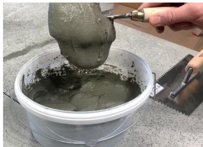
Bild 2: Fliesenkleber mischen
