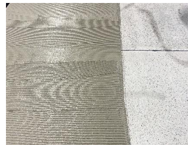
Bild 3: Fliesenkleber aufbringen
