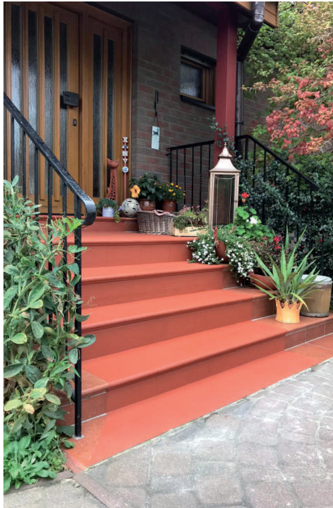
Treppe mit Antirutschbeschichtung.
